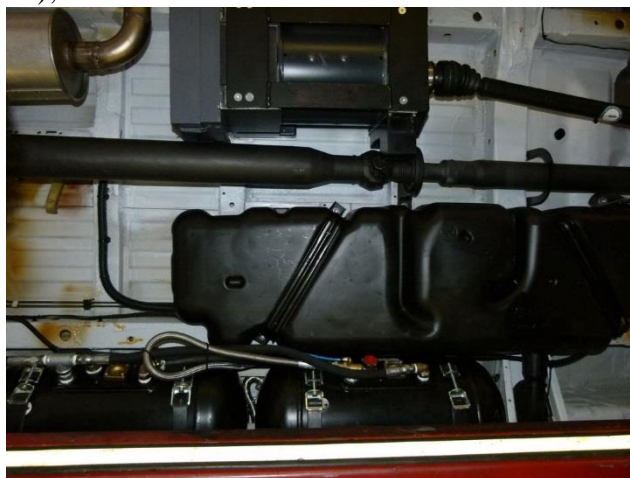
Generator și rezervoare de aer sub mașină
